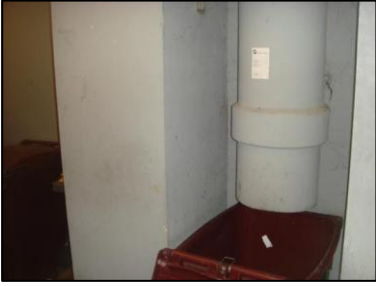
Photo N° 6155 AMIANTE CIMENT - -LOCAL VO RDC à +4 Vide-ordures Gain V.O.(Fibres-ciment)
